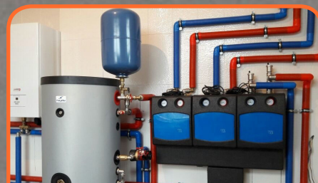
Тепловая изоляция трубопроводов и оборудования
