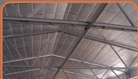
Утепление ограждающих конструкций
